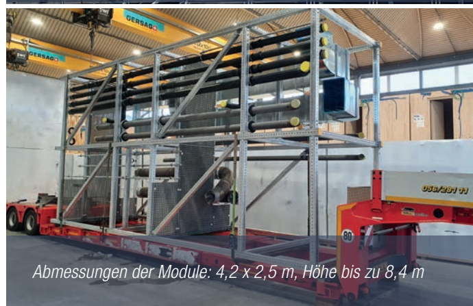
Die Module wurden mit einem Kran über die Bauöffnungen ins Gebäude eingebracht.
