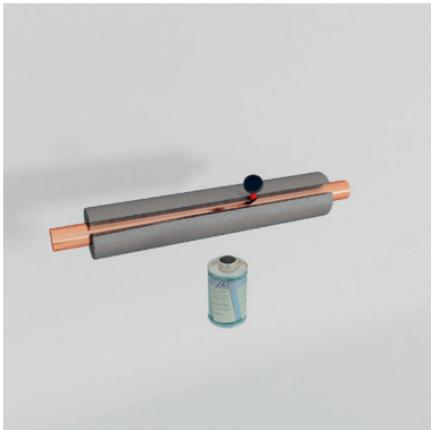
... um das Rohr legen und Schlitz mit NMC-FIX® beidseitig dünn einstreichen und nach vorgeschriebener Abluftzeit des Klebers (Fingertest) die Isolierung zusammenpressen. Bei Problemstellen, wie z.B. Muffen, empfehlen wir einige Clipse einzudrücken.
